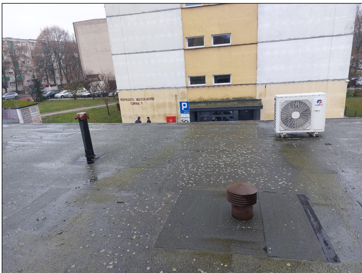
FOT. 151 – USZKODZENIE WYWIEWKI KANALIZACYJNEJ
