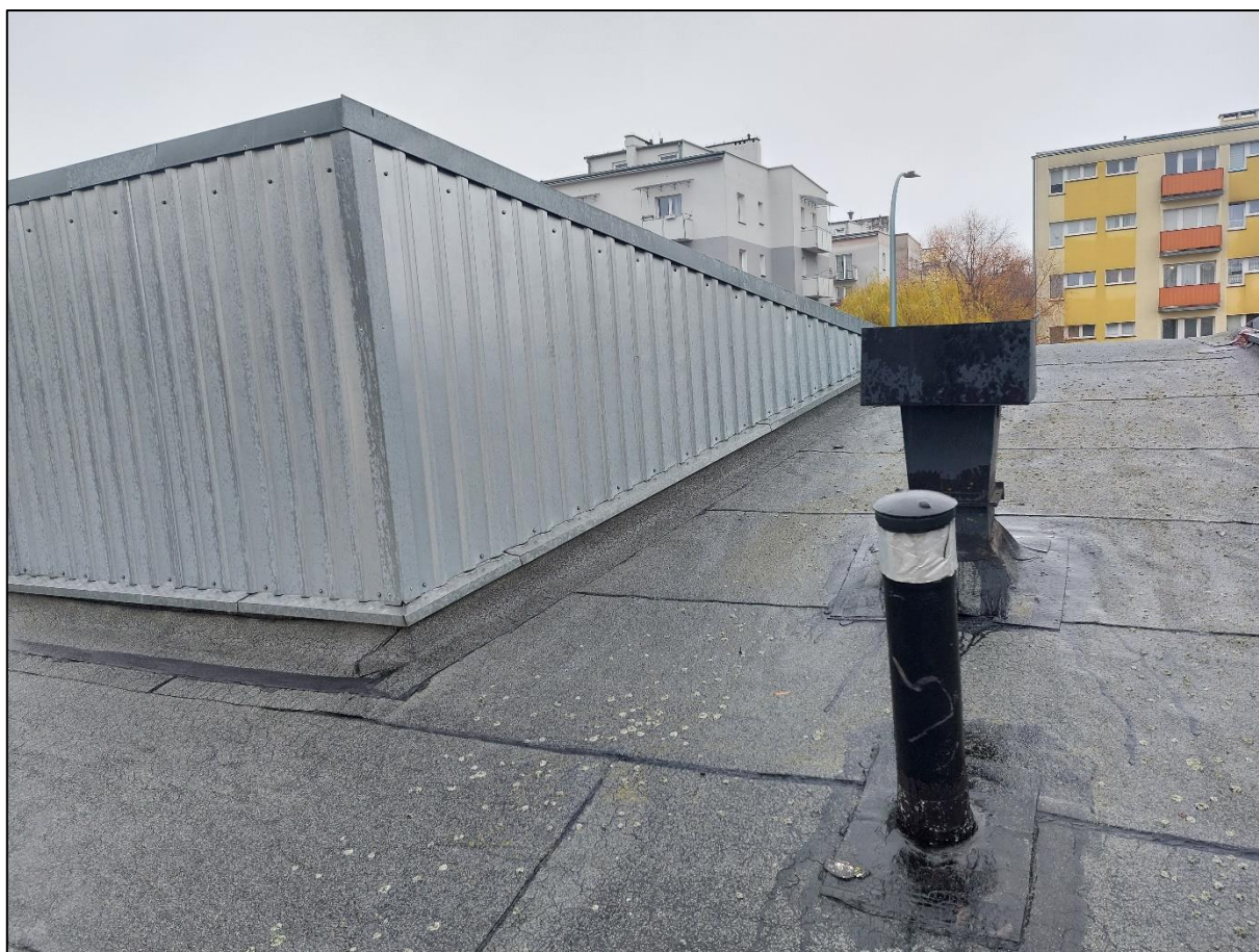
FOT. 150 – USZKODZENIE WYWIEWKI KANALIZACYJNEJ
