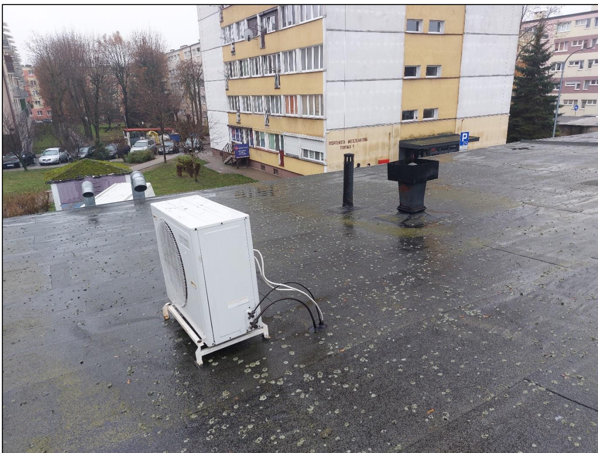
Fot. 145 – BRAK OSŁONY PRZEWODÓW
