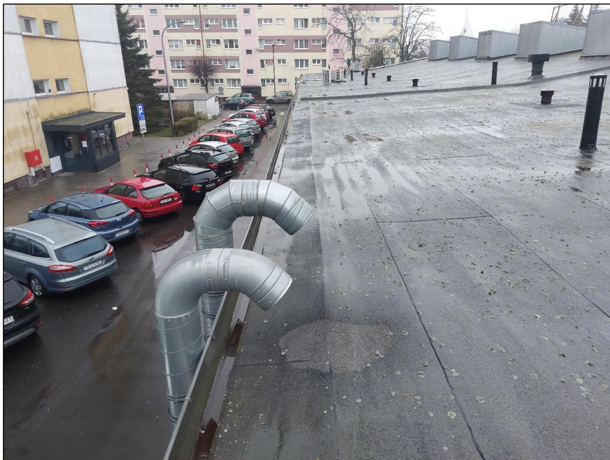
Fot. 139 – ROZWIĄZANIA ODPROWADZENIA SKROPLIN
