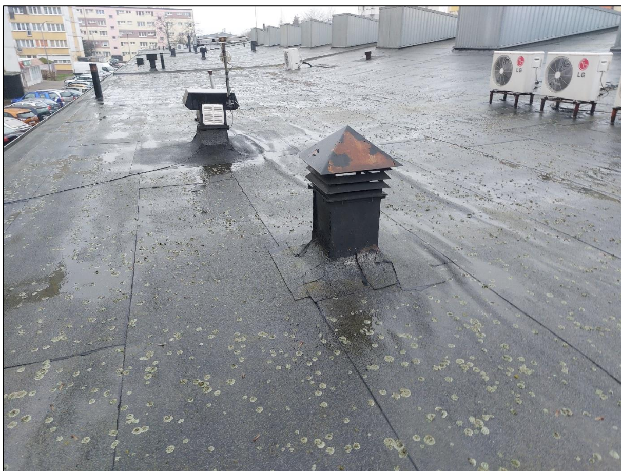
Fot. 138 – KOROZJA CZAP
