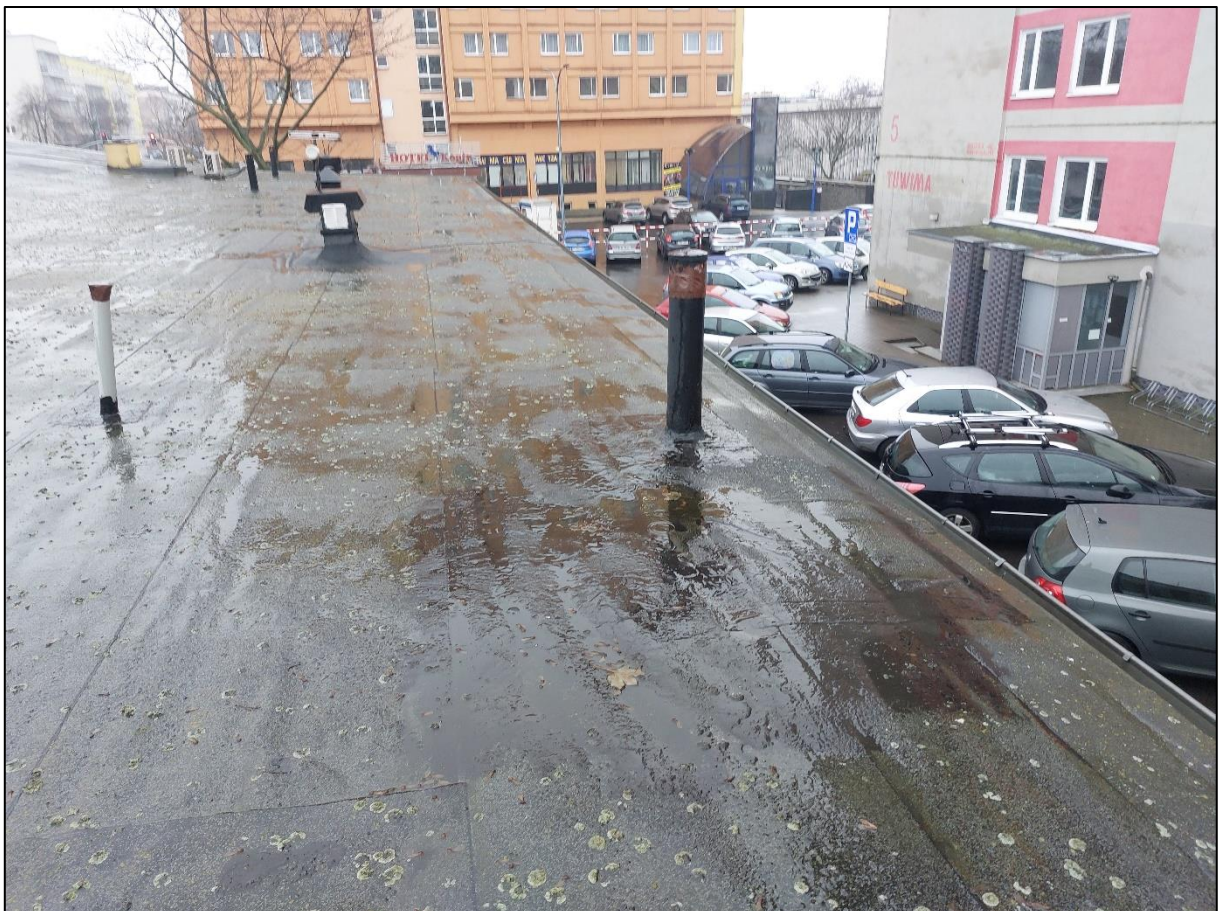
Fot. 149 – USZKODZENIE WYWIEWKI KANALIZACYJNEJ
