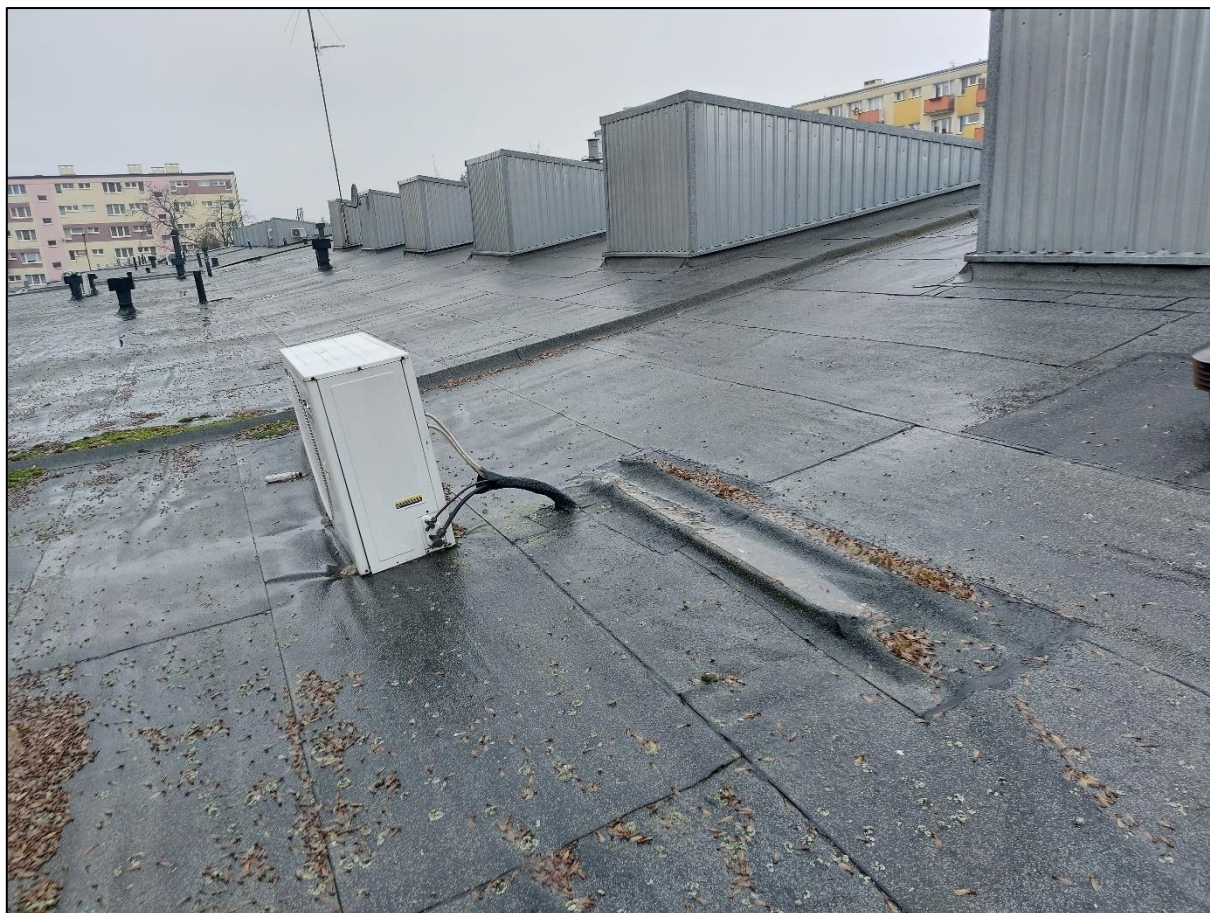
Fot. 133 – brak podstawy klimatyzatora
