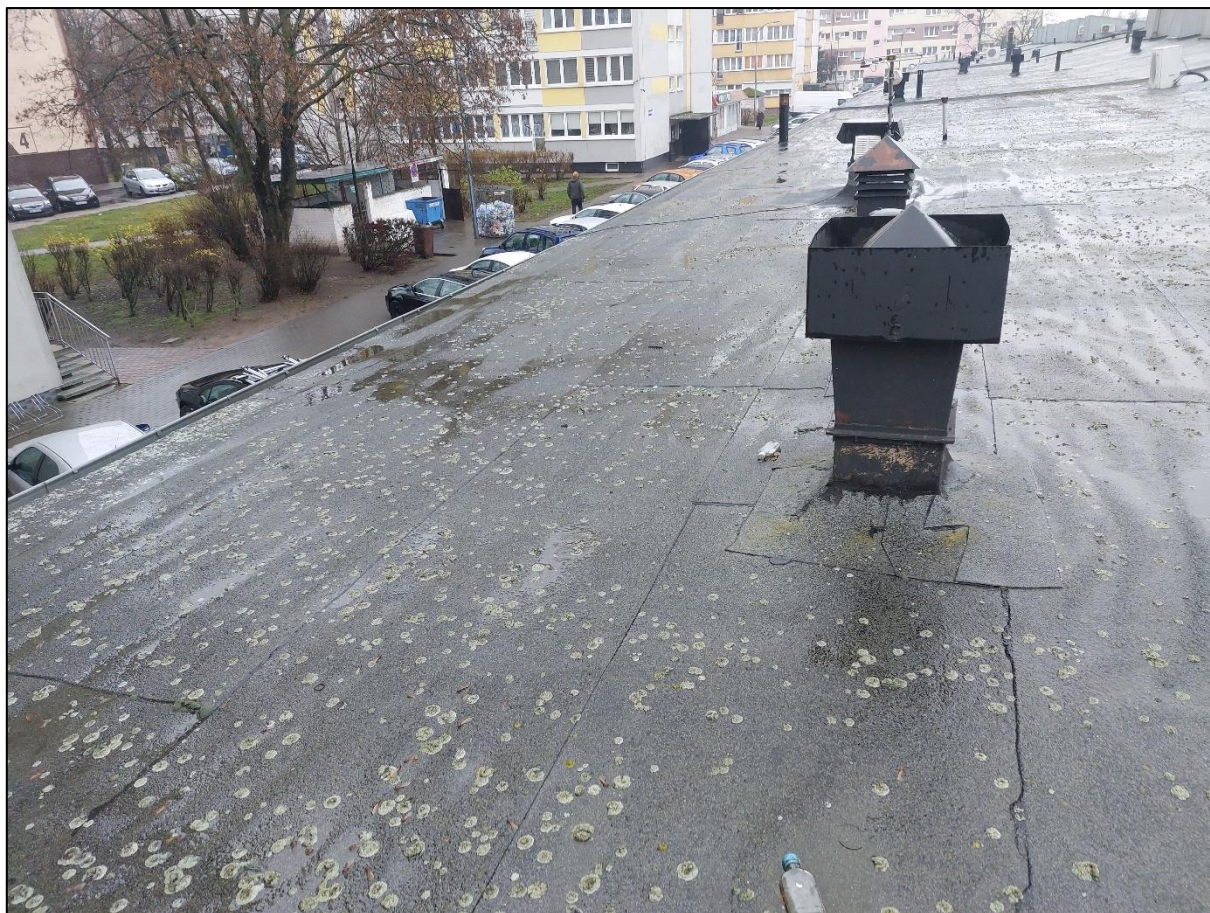
Fot. 137 - KOROZJA CZAP
